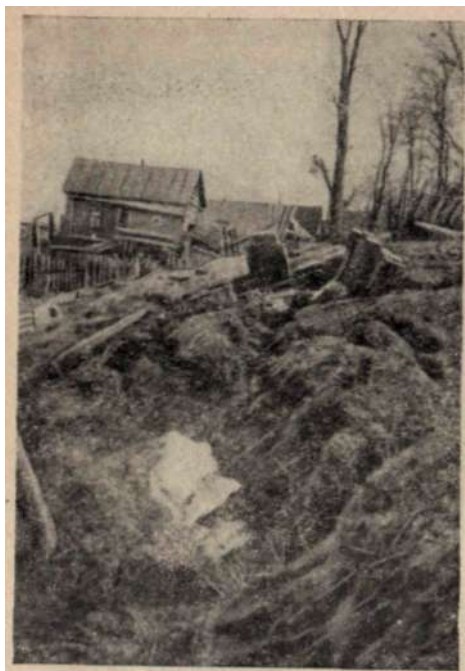
Оползень под Печерским монастырем в г. Горьком, происшедший в апреле 1947 года
